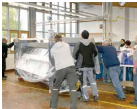
Viele Hände halfen: Die Mangel wurde durch das Lager und die E-Montage in die Wäscherei bugsiert.
